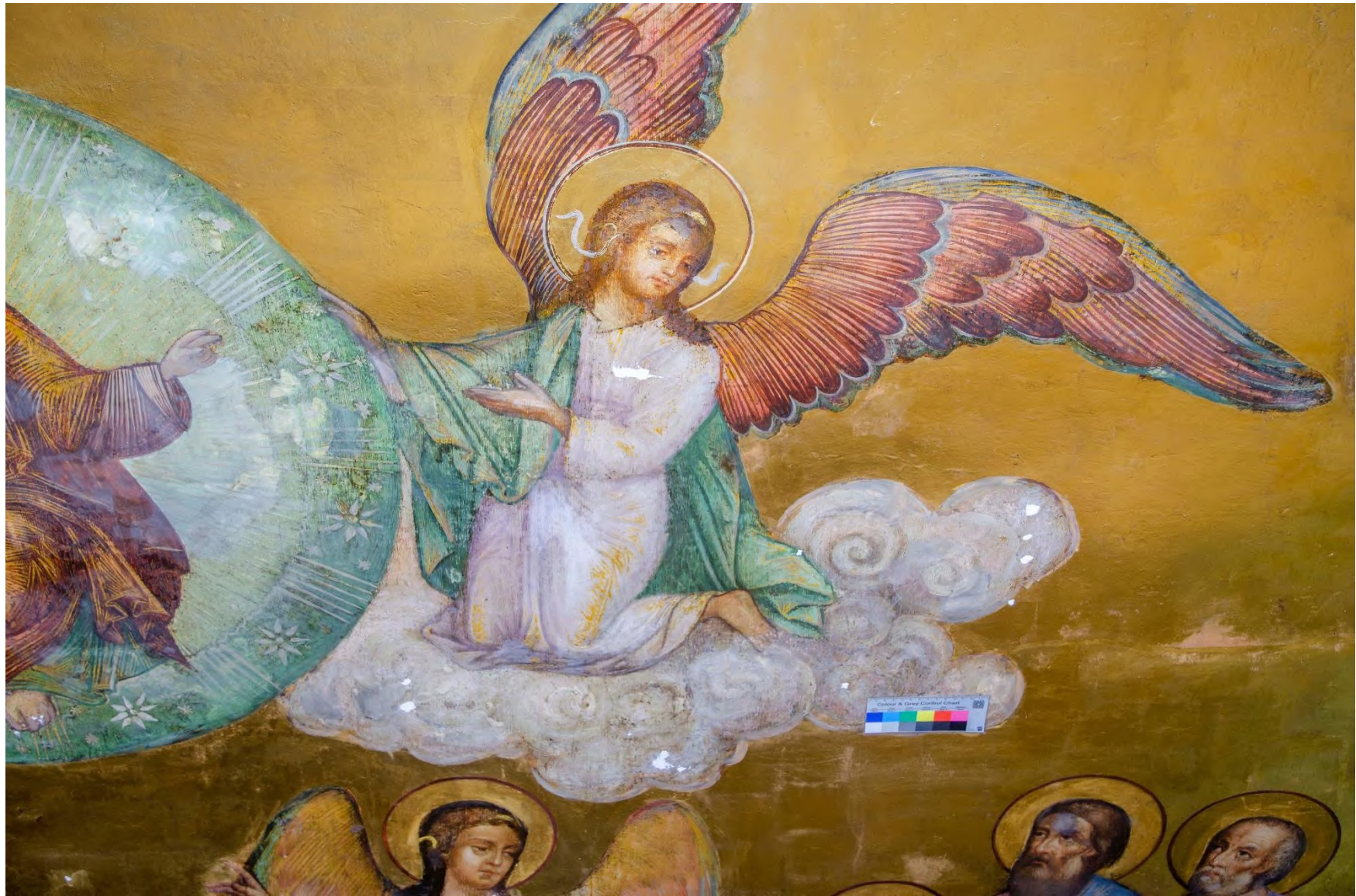
ОКН федерального значения "Церковь Всех Святых на Кулишках 1380 г. Перестроена в XVI-XVII в.в" по адресу: г. Москва, Славянская пл., д.2. Масляная монументальная живопись, 1877 г. с поновлением, реставрация 1990-х гг. Свод четверика, южный склон. Композиция "Вознесение Господне". Фрагмент. В процессе реставрации. Нанесение реставрационного грунта
