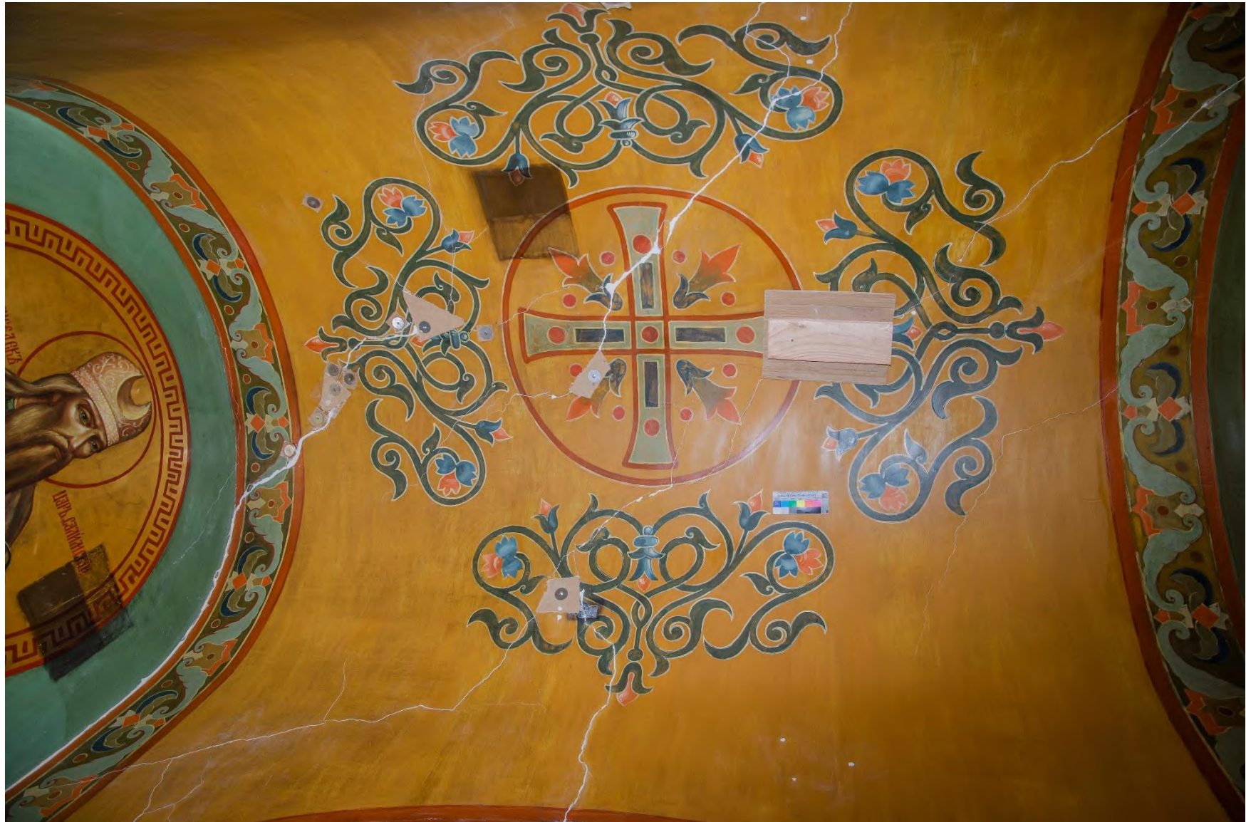
ОКН федерального значения "Церковь Всех Святых на Кулишках 1380 г. Перестроена в XVI-XVII в.в" по адресу: г. Москва, Славянская пл., д.2. Масляная монументальная живопись, 1877 г. с поновлением, реставрация 1990-х гг. диаконник алтаря Никольского придела, западный свод. Общий вид. В процессе реставрации. Укрепление штукатурного основания, заделка трещин
