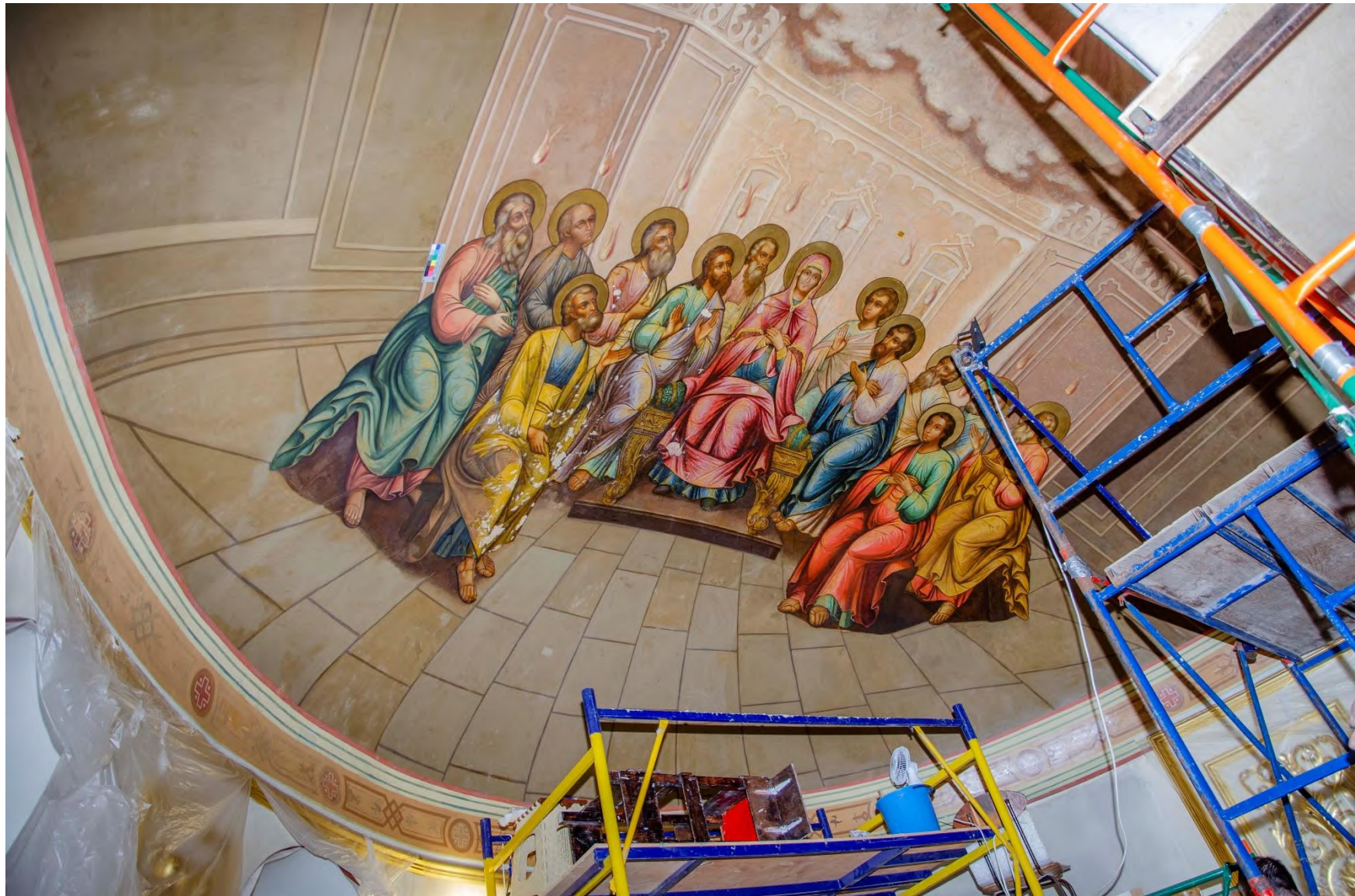
ОКН федерального значения "Церковь Всех Святых на Кулишках 1380 г. Перестроена в XVI-XVII в.в" по адресу: г. Москва, Славянская пл., д.2. Масляная монументальная живопись, 1877 г. с поновлением, реставрация 1990-х гг. Главный алтарь, свод. Композиция "Сошествие Святого Духа". Общий вид. В процессе реставрации. Удаление поверхностных загрязнений, копоти, потемневшего лака и фрагментарных масляных записей
