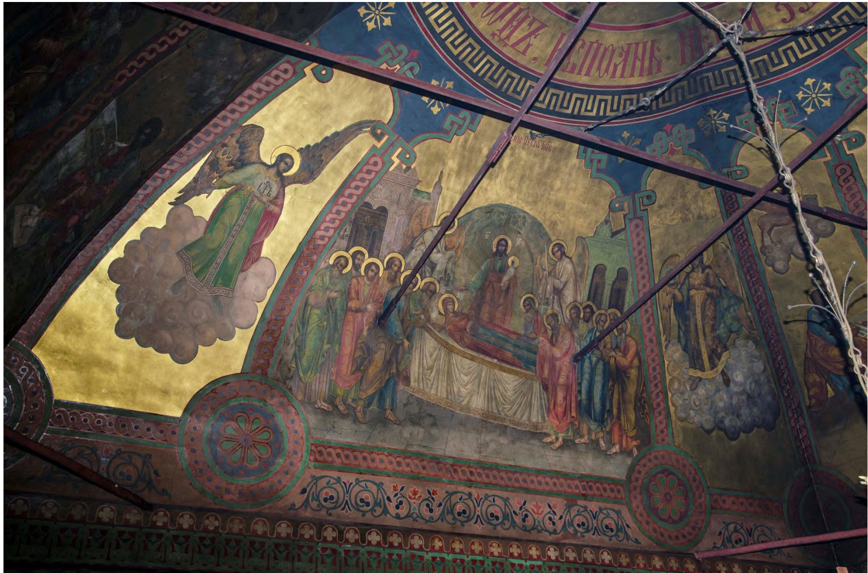
ОКН федерального значения "Церковь Всех Святых на Кулишках 1380 г. Перестроена в XVI-XVII в.в" по адресу: г. Москва, Славянская пл., д.2. Масляная монументальная живопись, 1877 г. с поновлением, реставрация 1990-х гг. Свод четверика, западный склон. Общий вид. До реставрации
