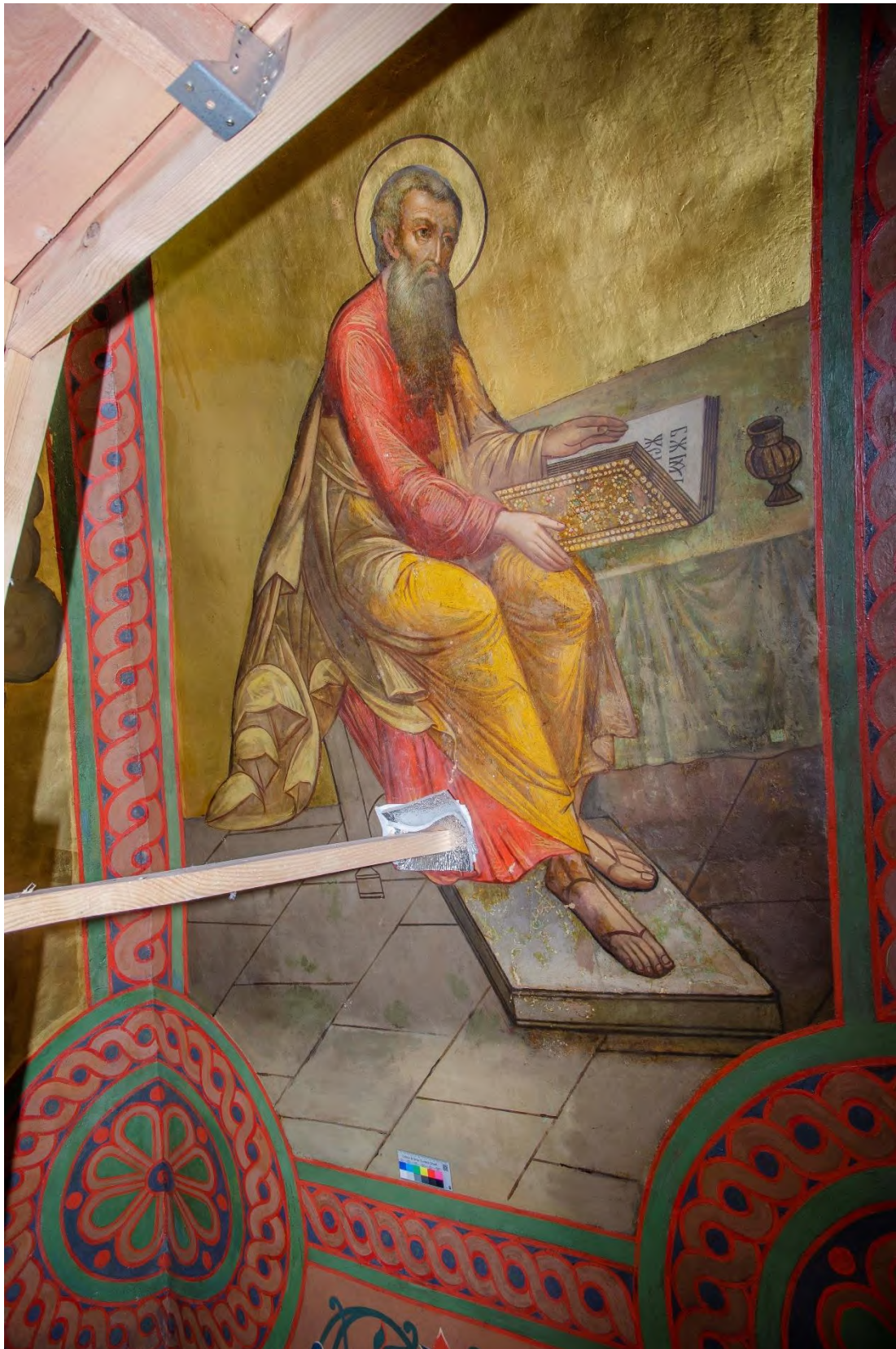
ОКН федерального значения "Церковь Всех Святых на Кулишках 1380 г. Перестроена в XVI-XVII в.в" по адресу: г. Москва, Славянская пл., д.2. Масляная монументальная живопись, 1877 г. с поновлением, реставрация 1990-х гг. Свод четверика, южный склон. Композиция "Евангелист Матфей". Фрагмент. Фрагмент. В процессе реставрации. Укрепление штукатурного основания
